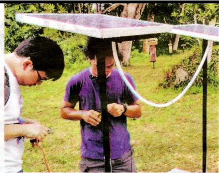
Pemasangan lampu jalan menggunakan Teknologi PV Solar Bersama Sistem Pemantauan IoT.
